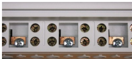
Obr. 3 Propojka spojena - provozní režim
