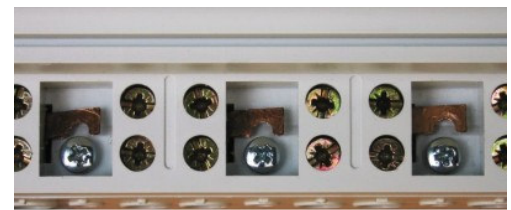
Obr. 4 Propojka rozpojena - zkušební režim
